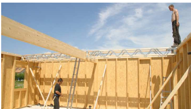
Obr. 45 Montáž stropních POSI nosníků
