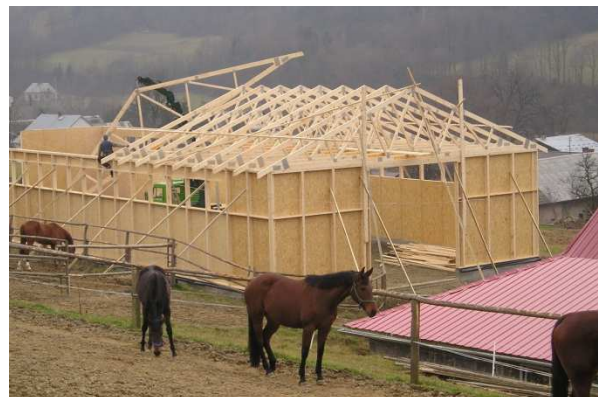
Obr. 20 Zastřešení stájí sedlovými vazníky
