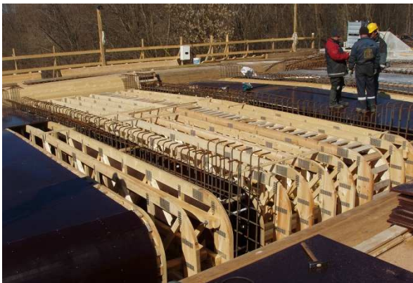
Obr. 26 Ramenáty pro bednění mostu
