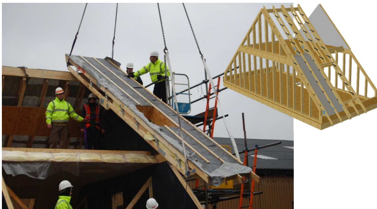
Obr. 46 Montáž střešních POSI nosníků
