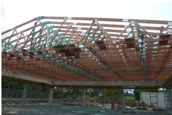
Obr. 19 Zastřešení haly sedlovými vazníky
