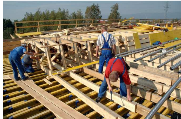
Obr. 23 Montáž raménátů pro bednění mostu
