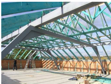
Obr. 37 Nástavba bytového domu
