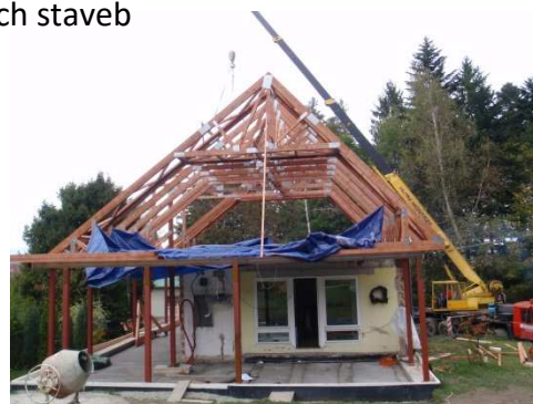
Obr. 29 Podkrovní vazníky na RD
