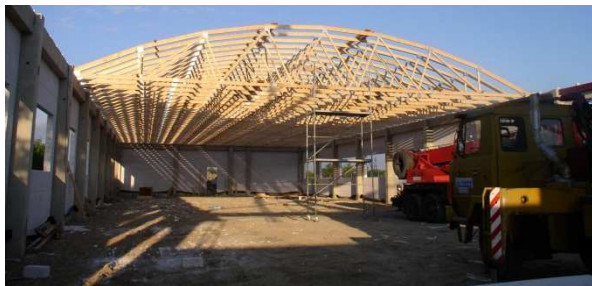
Obr. 17 Zastřešení haly na ocelové konstrukci
