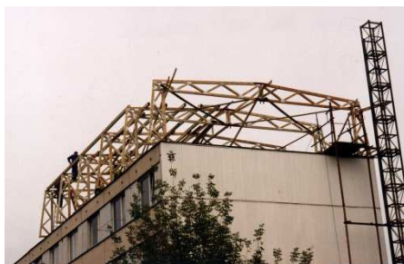
Obr. 35 Nástavba panelového domu
