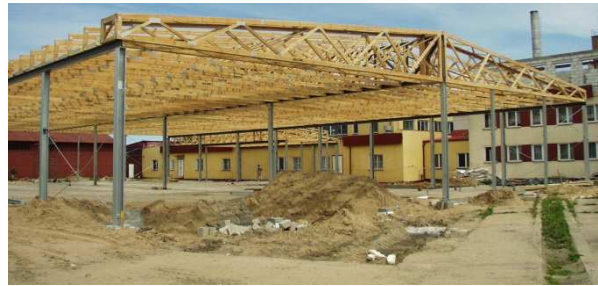
Obr. 18 Zastřešení výrobní haly obloukovými vazníky
