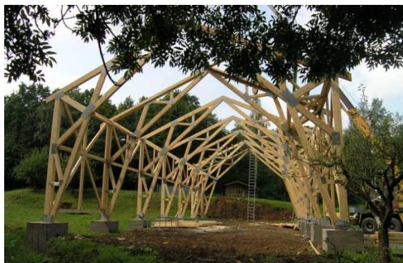
Obr. 13 Portálová konstrukce seníku
