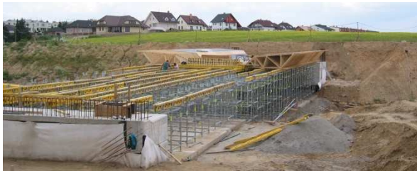
Obr. 24 Ramenáty pro bednění mostu
