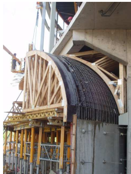
Obr. 27 Bednění sportovního stadionu
