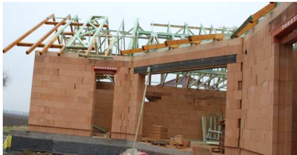
Obr. 10 Konstrukce vazníkové střechy s příznanými krokviemi
