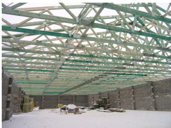
Obr. 11 Zastřešení výrobní haly sedlovými vazníky
