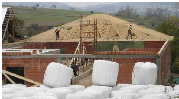
Obr. 21 Zastřešení výrobní haly sedlovými vazníky
