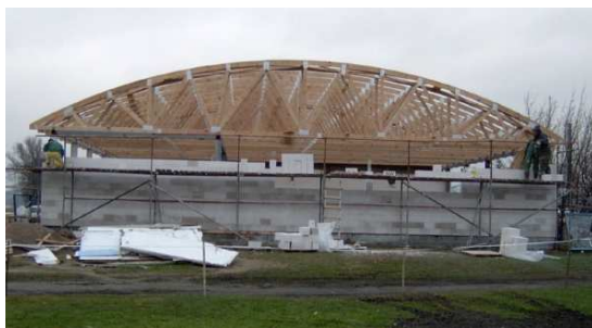
Obr. 33 Obloukové vazníky nad výrobní halou
