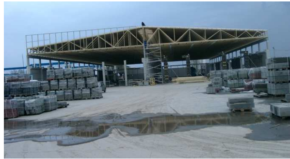
Obr. 22 Zastřešení skladovací haly sedlovými vazníky
