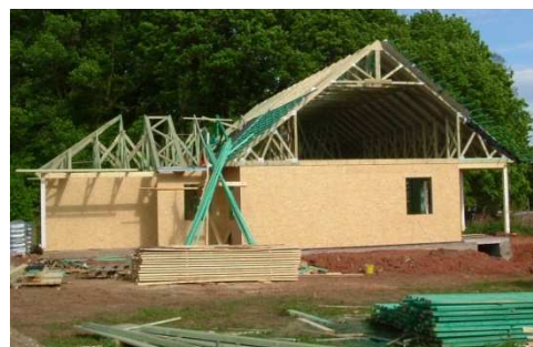
Obr. 28 Podkrovní vazníky na RD
