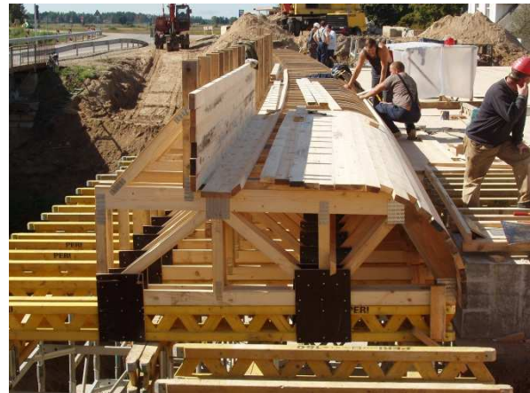
Obr. 25 Montáž raménátů pro bednění mostu
