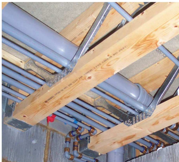
Obr. 43 Detail vedení rozvodů TZB
