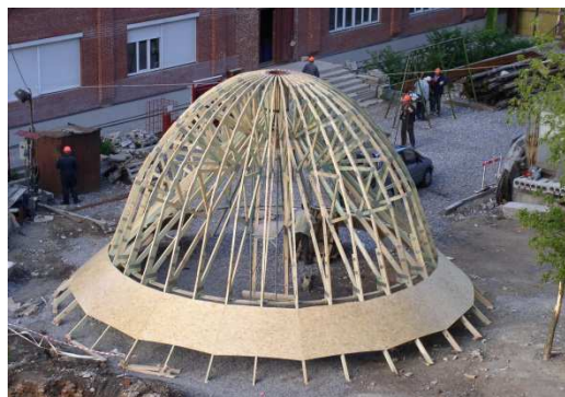
Obr. 8 Konstrukce věže kostela
