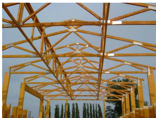
Obr. 9 Konstrukce skladu soli
