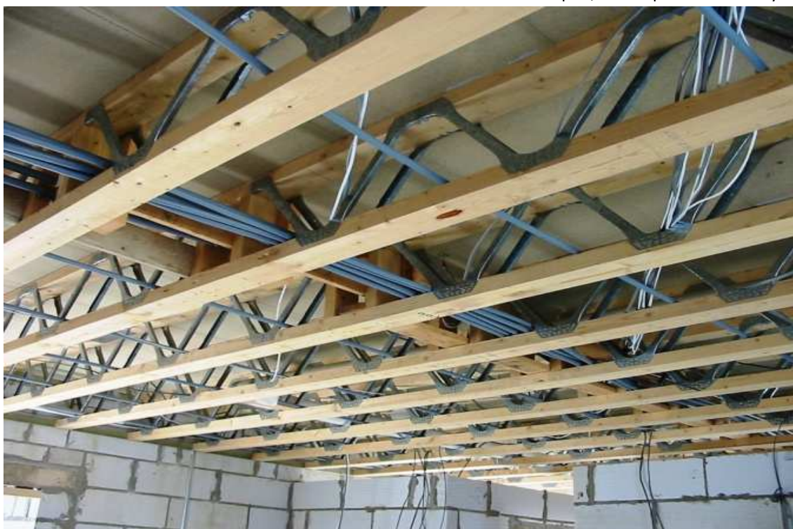
Obr. 42 Pohled ze spod, na stropní POSI nosníky
