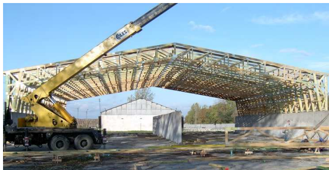
Obr. 34 Portálové vazníky nad silážní jámou
