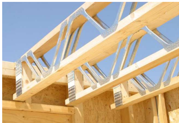
Obr. 40 Detail uložení stropních POSI nosníků
