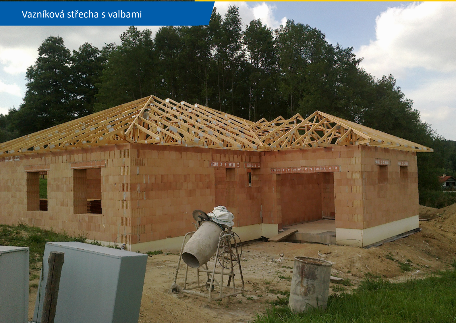
Valbová střecha na zděné stavbě
