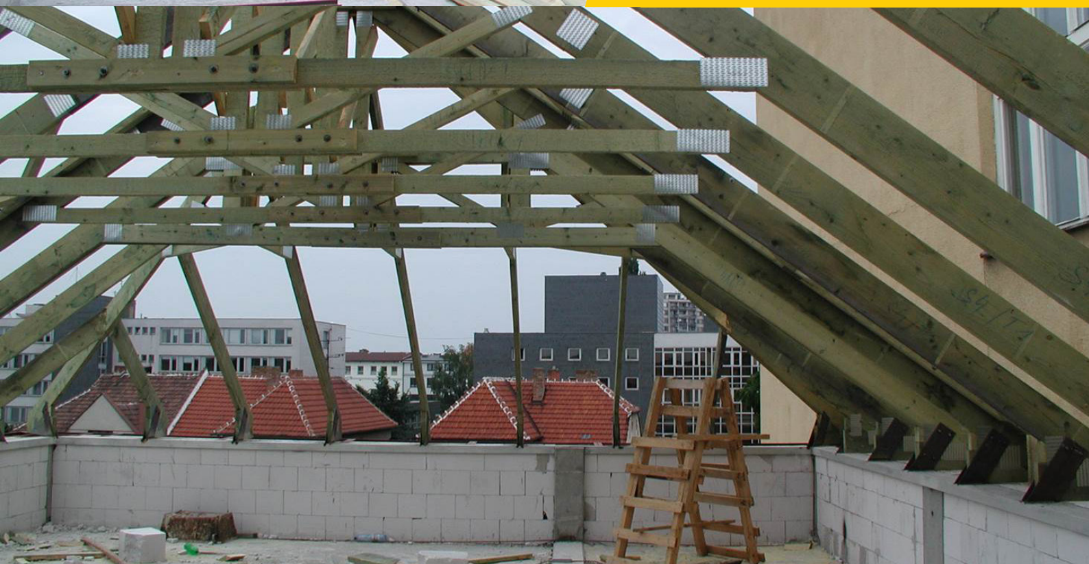
Vazníky na betonovém stropě
